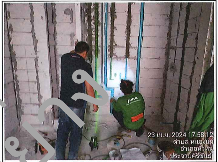
ติดตั้งท่อน้ำดีในผนัง ชั้น 8
