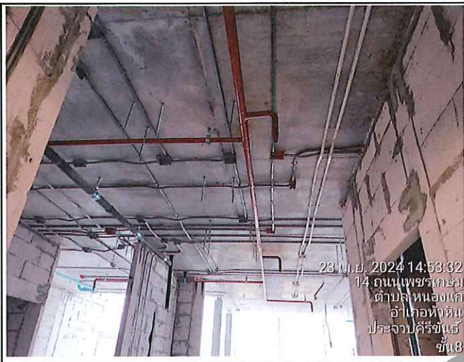
งานติดตั้งตำแหน่งหัว SPK. ห้องพัก ชั้น 8*
