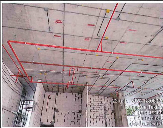
ติดตั้งท่อคัปเพิลจิง ชั้น 1*
