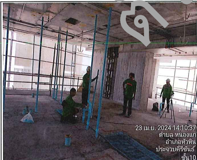
งานติดตั้งท่อน้ำ W,KW,V ชั้น 10
