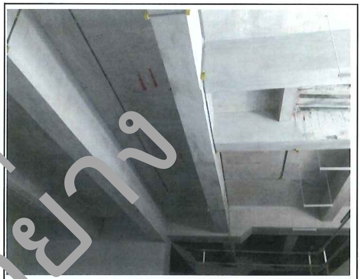
งานเดินท่อท้องพื้นของงาน LIGHTING, EMERGENCY AND EXIT LIGHT SYSTEM ชั้น B
