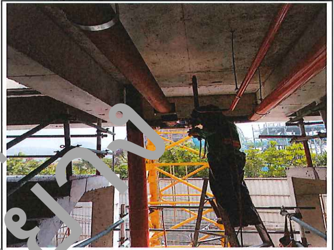
ติดตั้งท่อ Riser คัปเพิลจิง ชั้น 3*
