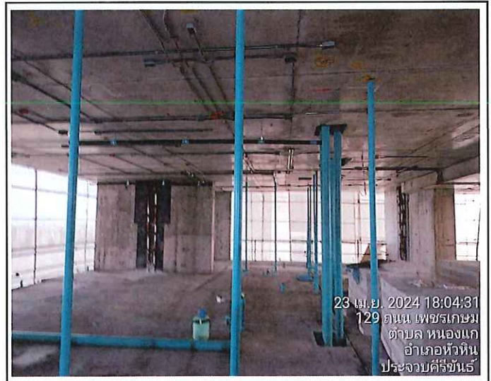
งานติดตั้งท่อน้ำ W,KW,V ชั้น 10
