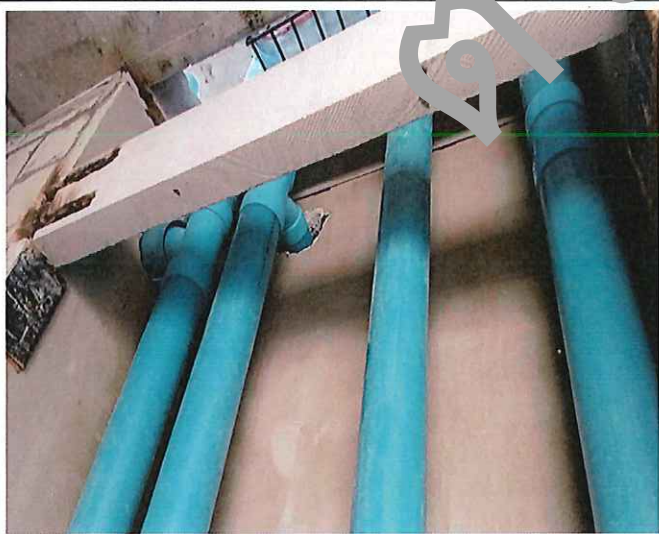
ติดตั้งท่อเมน Riser S,W,KW,V ชั้น 8
