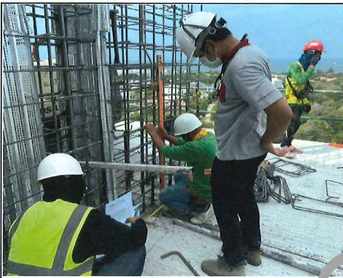
งานติดตั้งท่อ, BOX ฝังเสา SLEEVE FOR FIXTURE FOR 6th FLOOR (PART 2)
