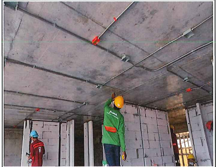
งานติดตั้ง SUPPORT ท่อน้ำยาแอร์ ทางเดินชั้น 8
